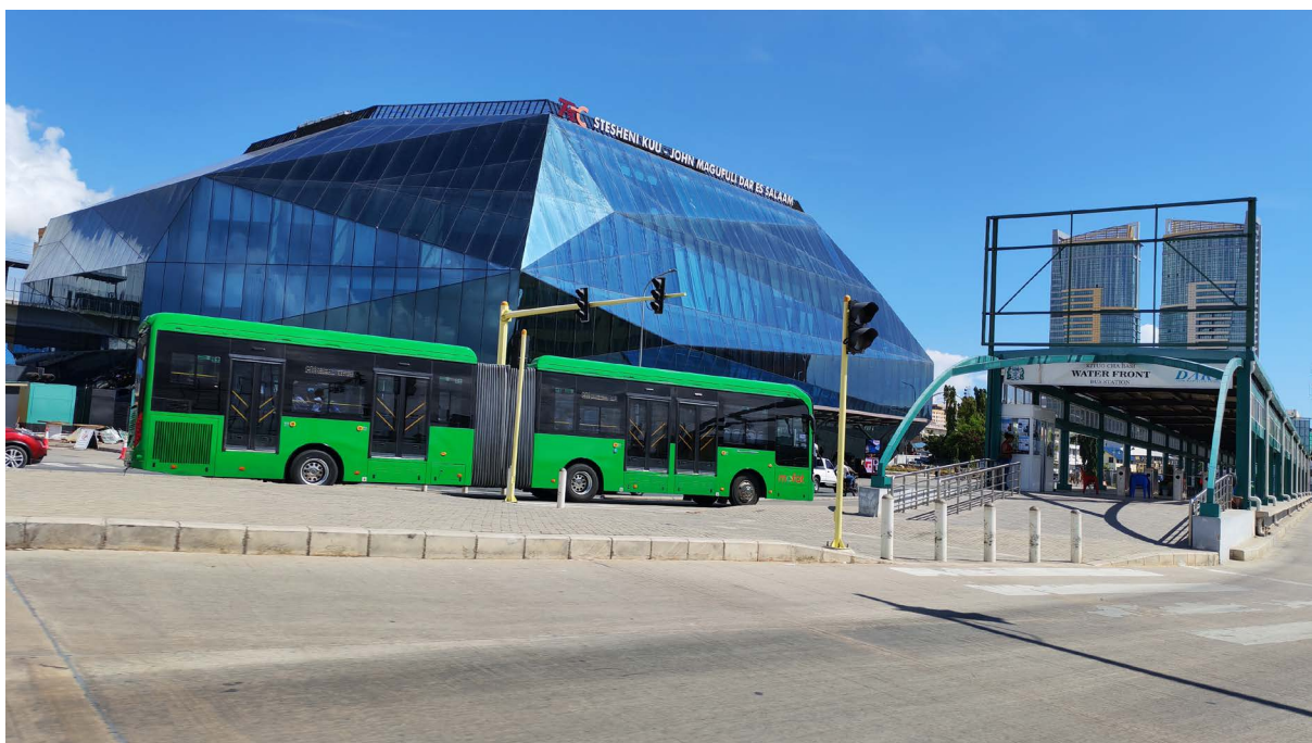
BRT de Dar Es Salam (2026) ©Transitec
