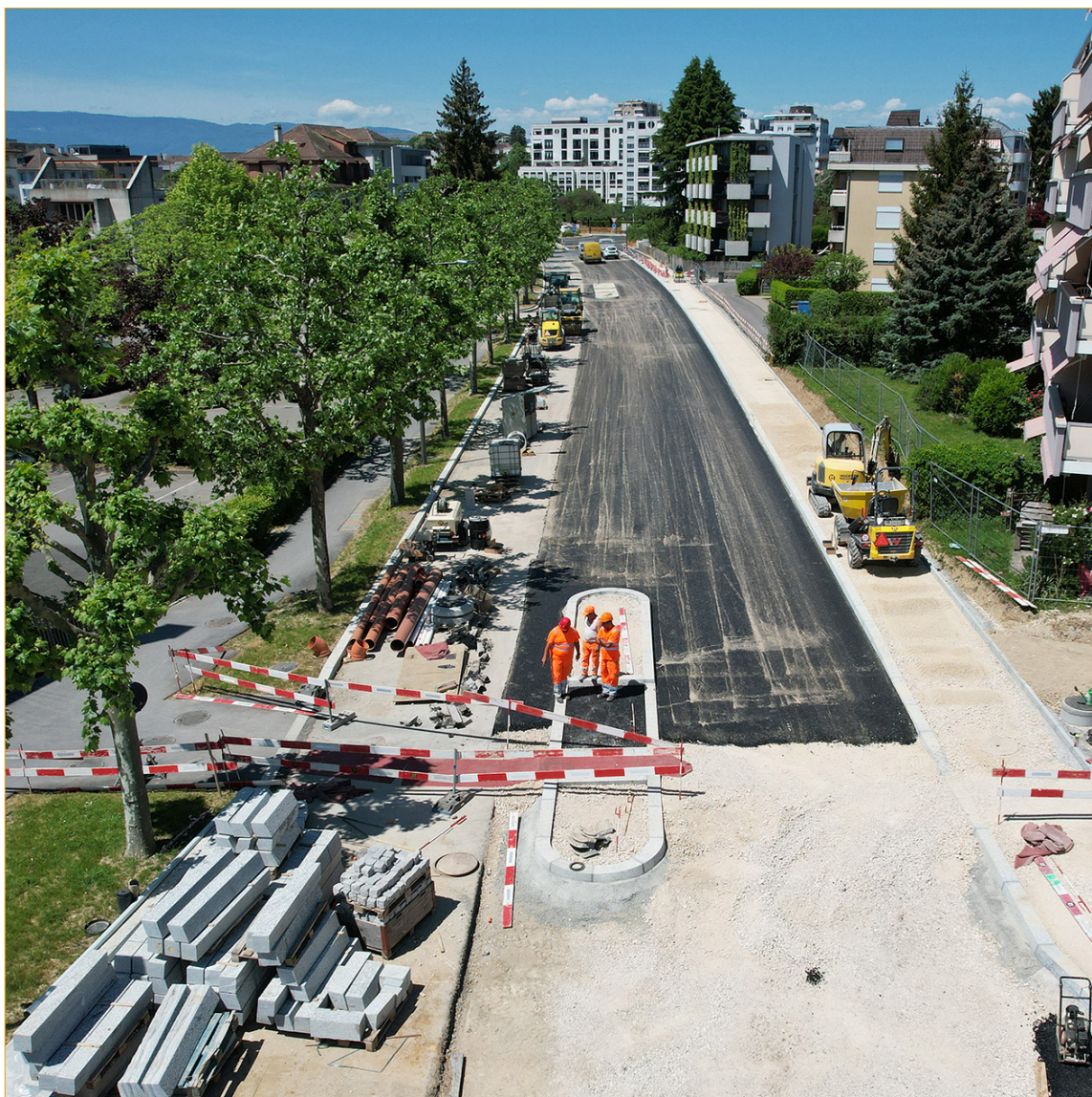
Chantier du tramway à Renens
